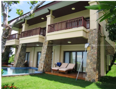
Diềm mái và lan can biệt thự
